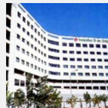
Hospital 9 de Octubre (VALENCIA)
